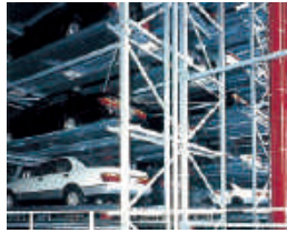
อาคารจัดวางซ้อนอัตโนมัติสำหรับรถยนต์ที่ประกอบเสร็จแล้ว
